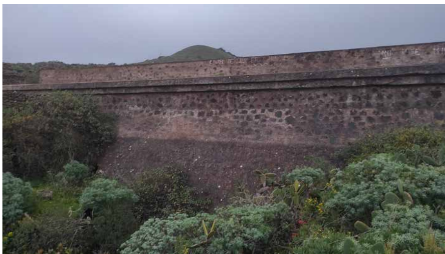
Figura 9.7. Presa de Tefirabe (El Mocanal, El Hierro). Pequeña presa de mampostería concebida para laminar escorrentías y apoyar el abastecimiento, hoy sin lámina de agua por la escasa aportación superficial en su cuenca.
