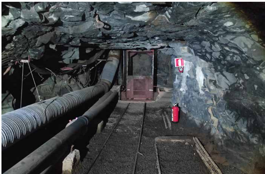
Figura 9.5. Pozo-galería de Los Padrones, ejecutado por la Dirección General de Aguas, al fondo se puede observar la caña del pozo de 52 metros y el elevador.
