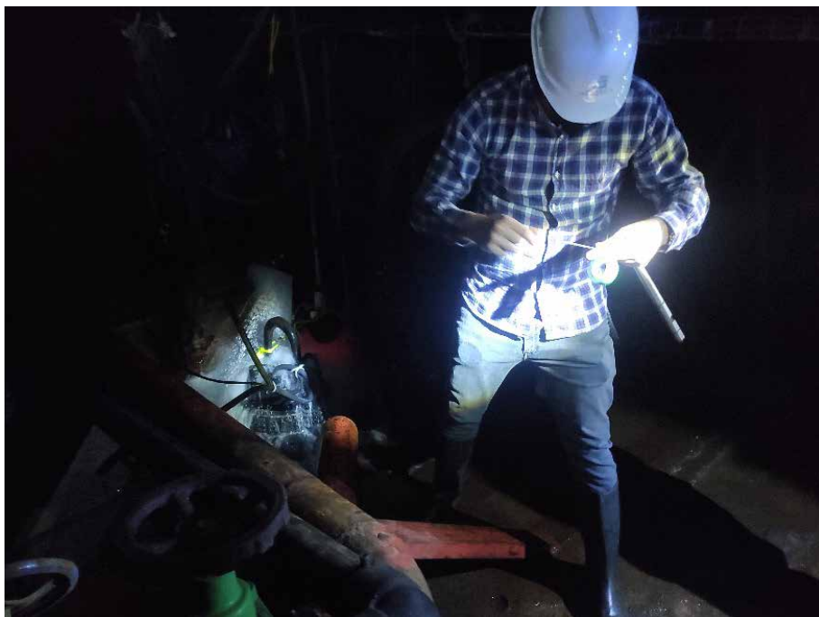
Figura 11.3. Instalación de un sensor multiparamétrico en un pozo-galería de la isla de El Hierro
