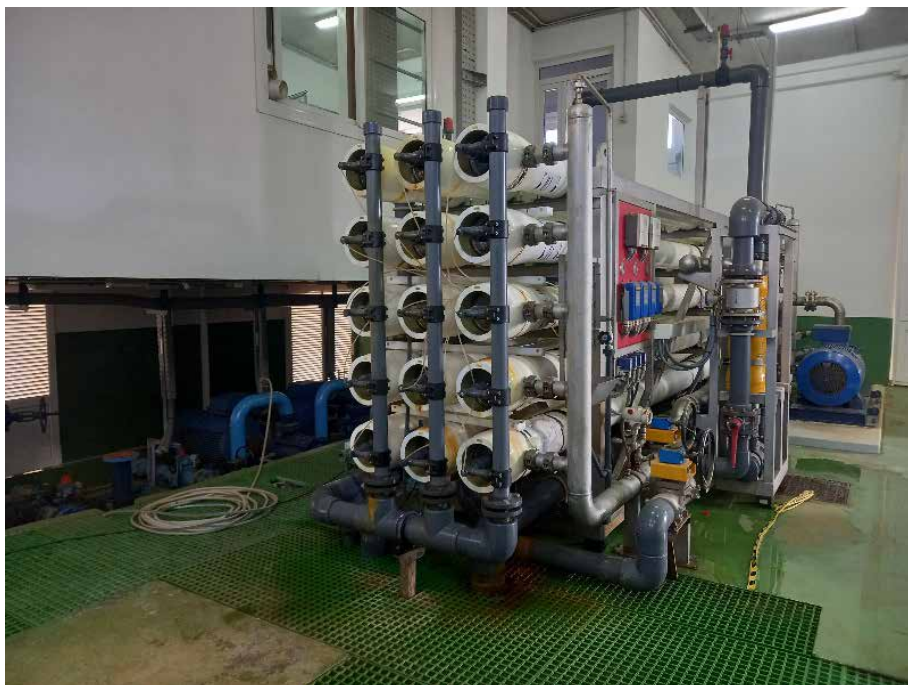
Figura 1.9. Bastidor de ósmosis inversa en una planta desalinizadora de agua de mar en la isla de El Hierro
